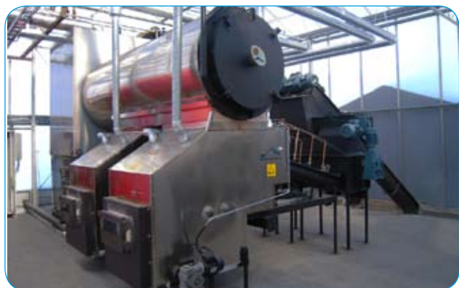
Bild från sidan inkl rensluckan till sekundärkammaren (röret).
