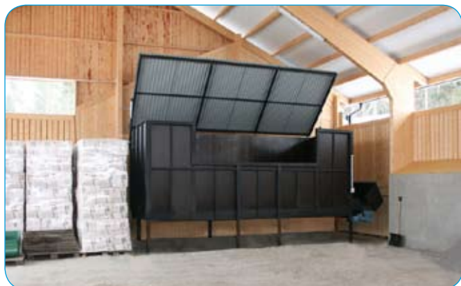
Swebo S.M.S förråd med hydraulisk taköppning.
