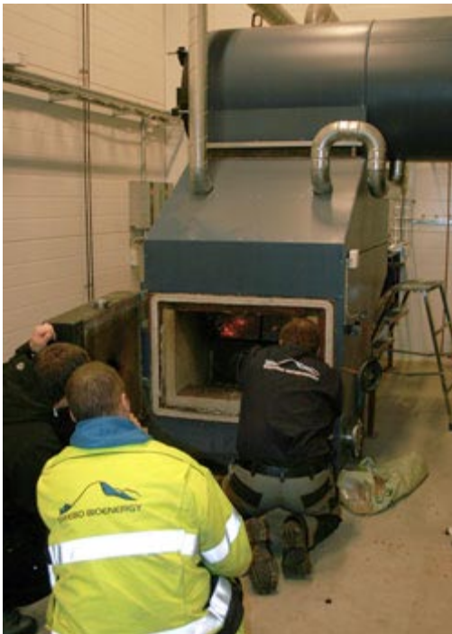
Kontroll av brännkammaren.
