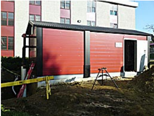
Uppförandet av SWEBO PHC 500 kW Pellets vid elevhemmet Granite Hall.
