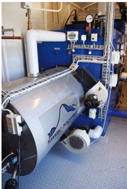
Värmeanläggning SWEBO PHC 500 kW pellets.
